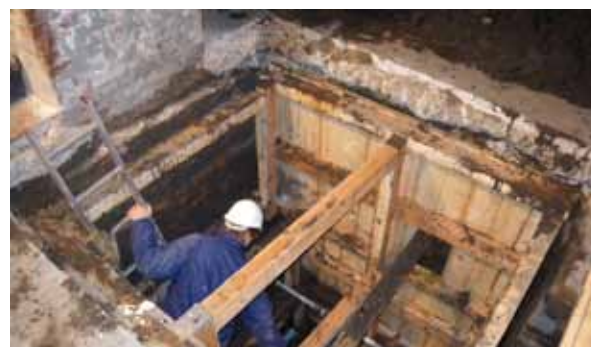
Visuele inspectie van de fundering
